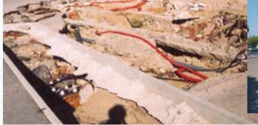
La voirie et les réseaux éventrés par le Vidourle, espace Lantaires, à Sommières en 2002...
