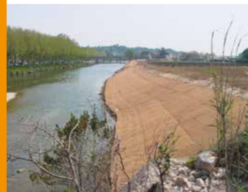
2003, le réaménagement de la traversée de Sommières par génie végétal
