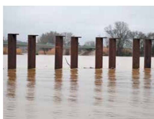
Crue du 02 février 2009, le peigne à embâcles retient des bois flottants
