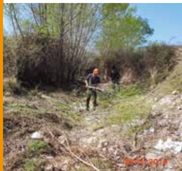
Travaux de nettoyage du ruisseau de la Courme par l'équipe Verte
